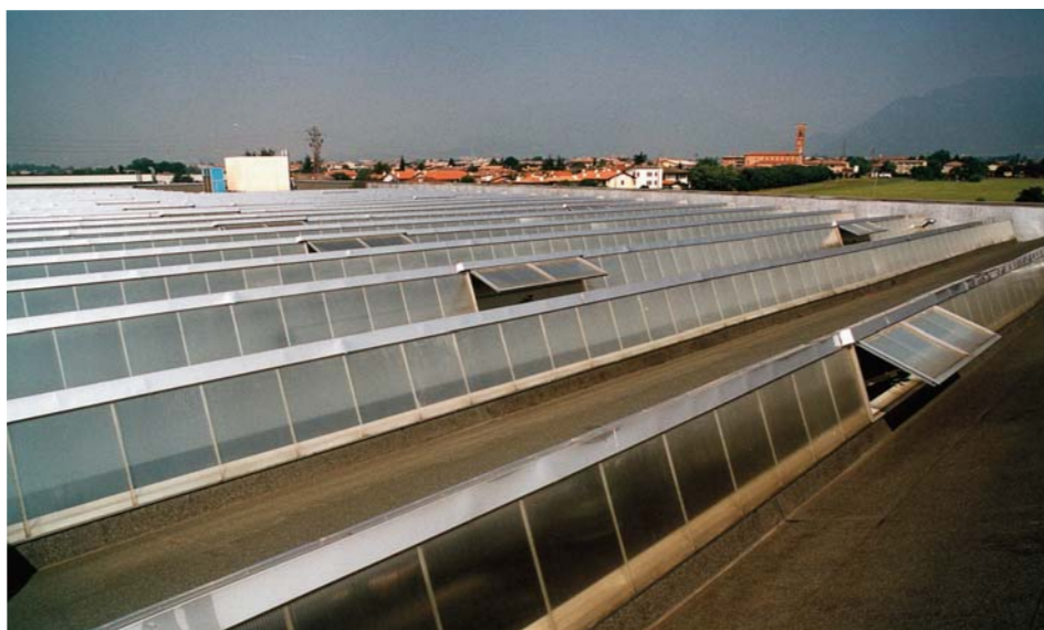
Vista dall'alto di una copertura serie "NEW SHED", con il particolare dell'inserimento del modulo apribile.
